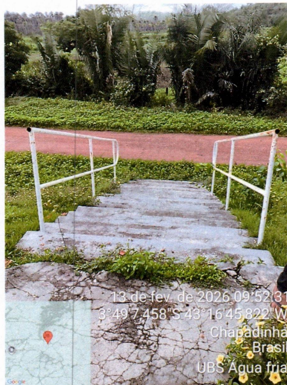
Imagem 3 – Escada de acesso.
