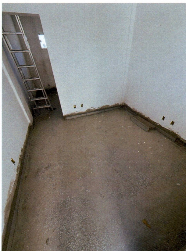
Imagem 8 – Execução de granilite e rodapés;
