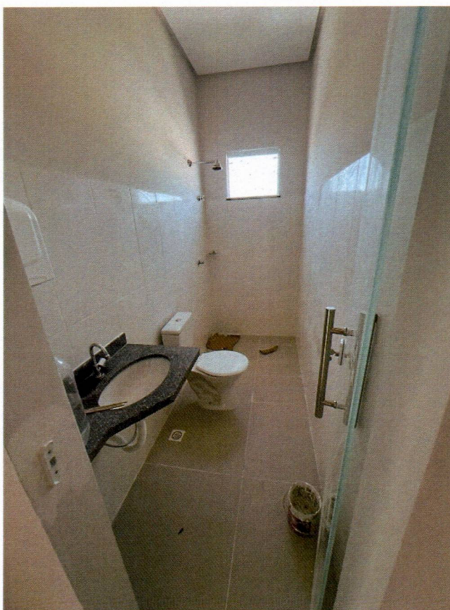
Imagem 20 – Execução de esquadrias, louças e metais;
