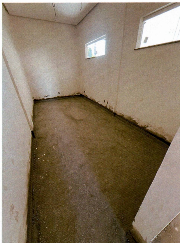
Imagem 6 – Execução de granilite, rodapé e esquadrias;
