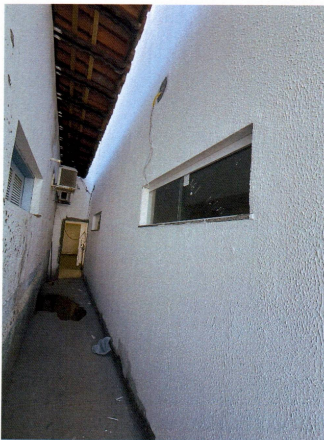
Imagem 4 – Execução de esquadrias;
