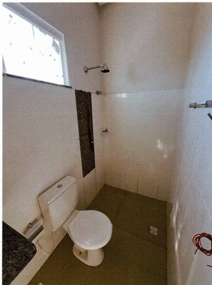
Imagem 15 – Execução de esquadrias, louças, metais e pisos porcelanatos;
