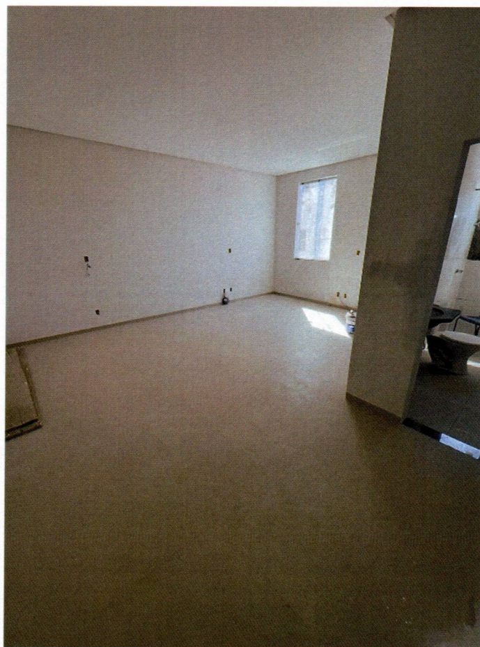
Imagem 16 – Execução de porcelanato e esquadrias;
