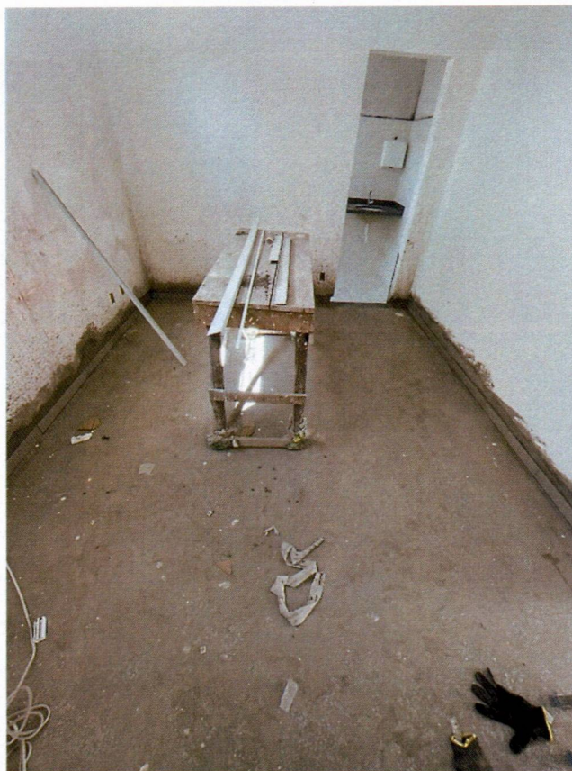
Imagem 9 – Execução de granilite e rodapés;
