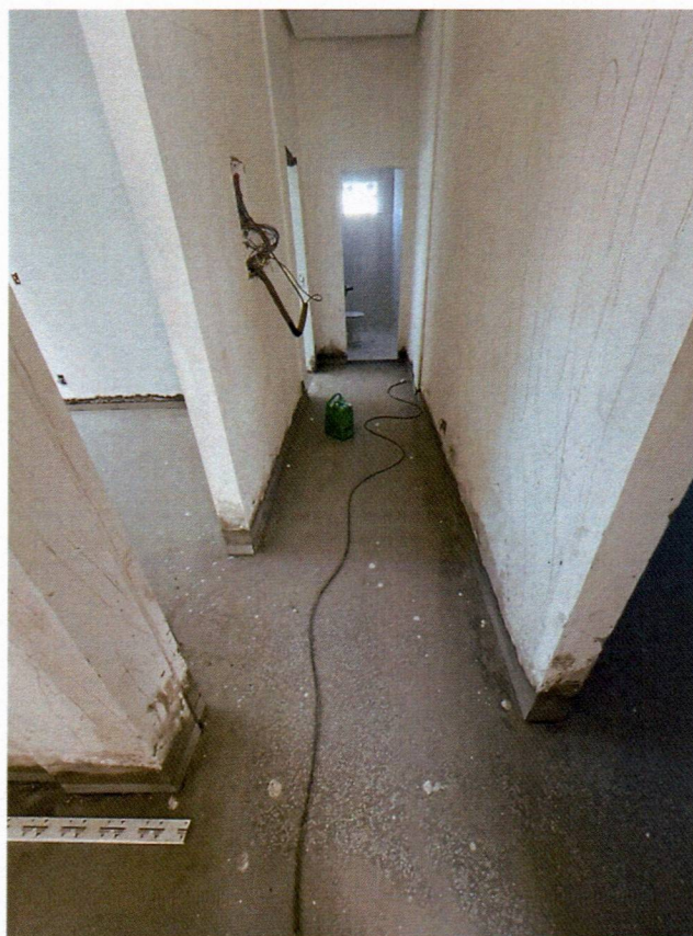
Imagem 10 – Execução de granilite e rodapés;
