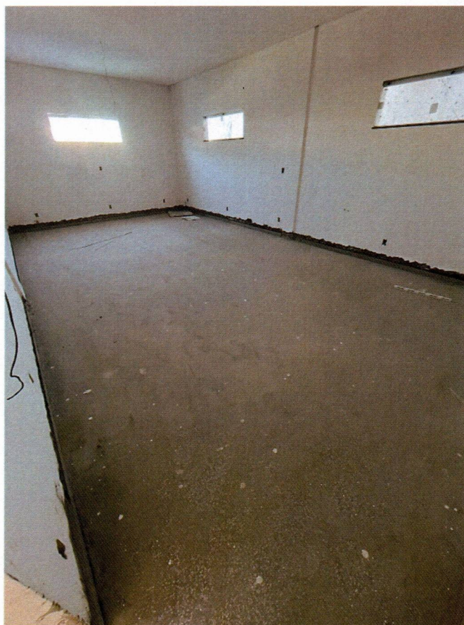
Imagem 11 – Execução de granilite e rodapés;
