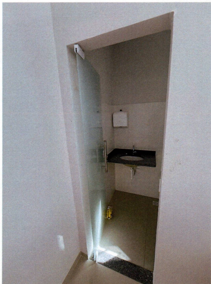
Imagem 13 – Execução de esquadrias, louças, metais e pisos porcelanatos;
