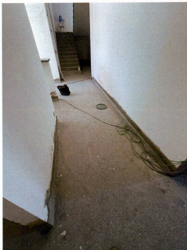
Imagem 5 – Execução de granilite e rodapés;
