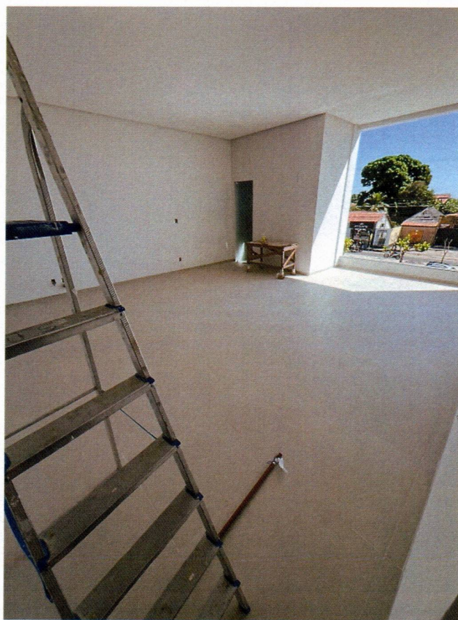
Imagem 14 – Execução de porcelanato e esquadrias;
