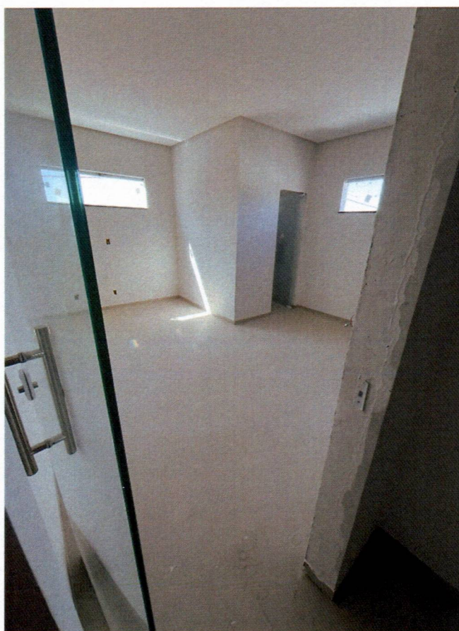
Imagem 22 – Execução de porcelanatos e esquadrias.
