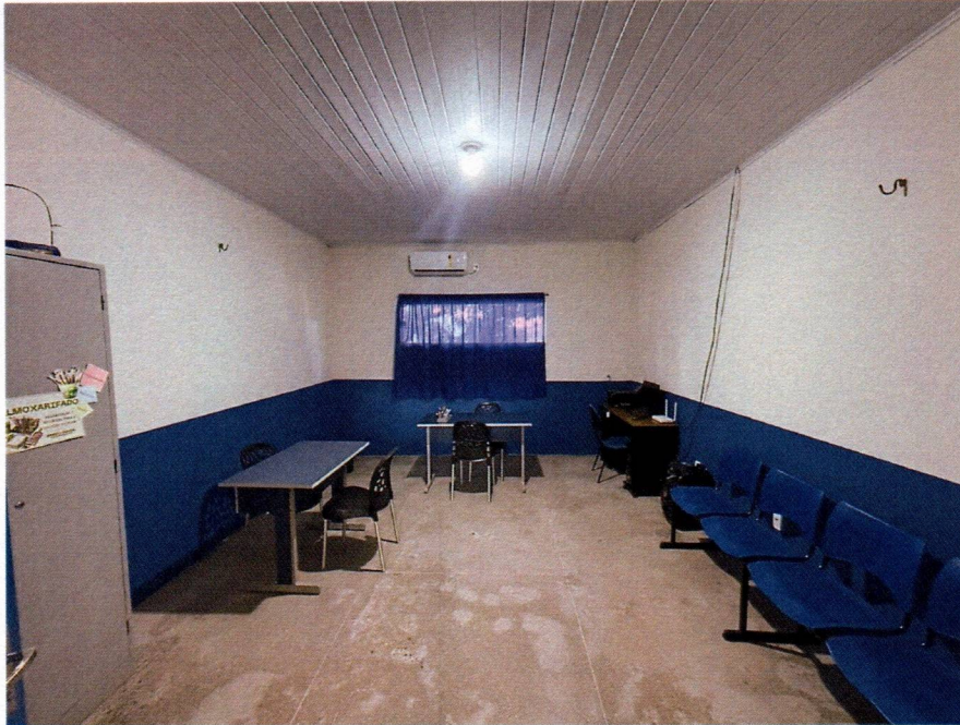
Imagem 7 – Pintura interna das salas.
