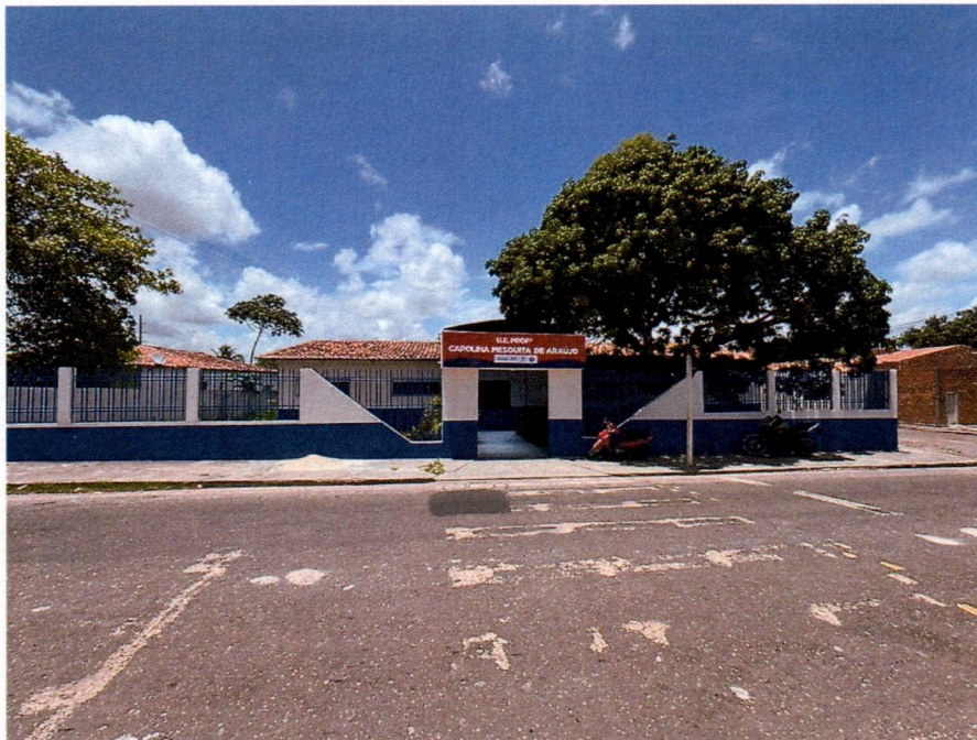
Imagem 1 – Pintura da fachada da escola.
