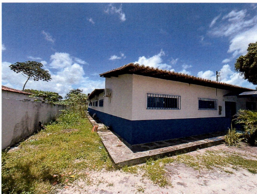
Imagem 2 – Pintura da fachada da escola.
