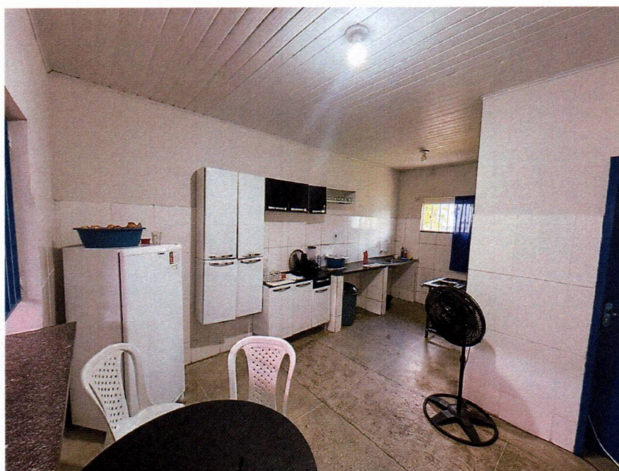
Imagem 12 – Pintura interna da cozinha.
