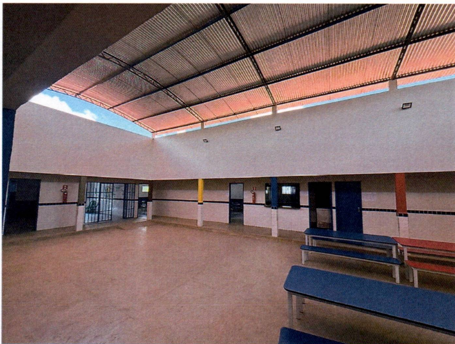
Imagem 6 – Pintura interna do pátio da escola.
