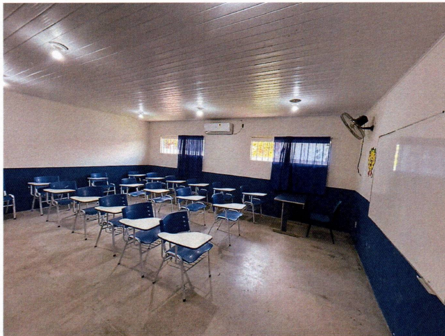
Imagem 8 – Pintura interna das salas.
