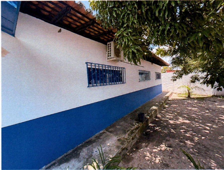
Imagem 3 – Pintura da fachada da escola.
