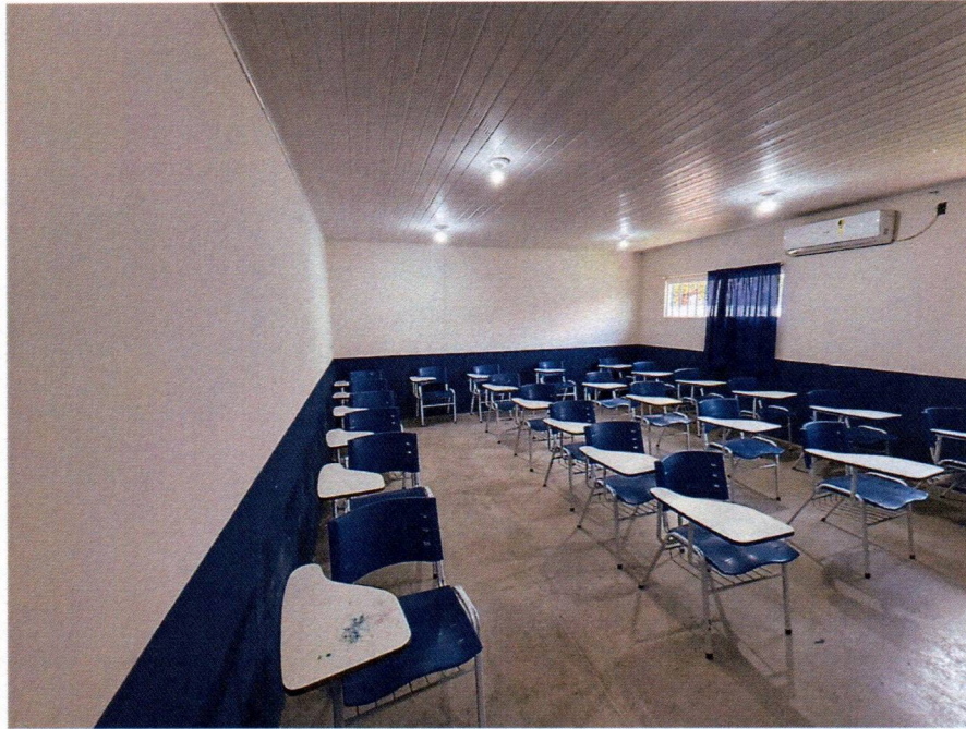
Imagem 9 – Pintura interna das salas.
