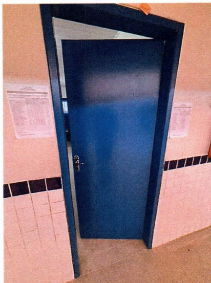
Imagem 11 – Pintura das esquadrias de madeira e substituição do trincos das portas.
