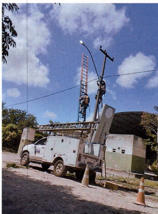
Figura 08: equipe em campo realizando substituições necessárias de Lâmpadas, cabo elétrico, conector, reator, arruela, braços com caminhonete adaptada.
