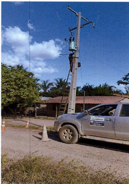
Figura 11: equipe em campo realizando substituições necessárias de Lâmpadas, cabo elétrico, conector, reator, arruela, braços com caminhonete adaptada.
