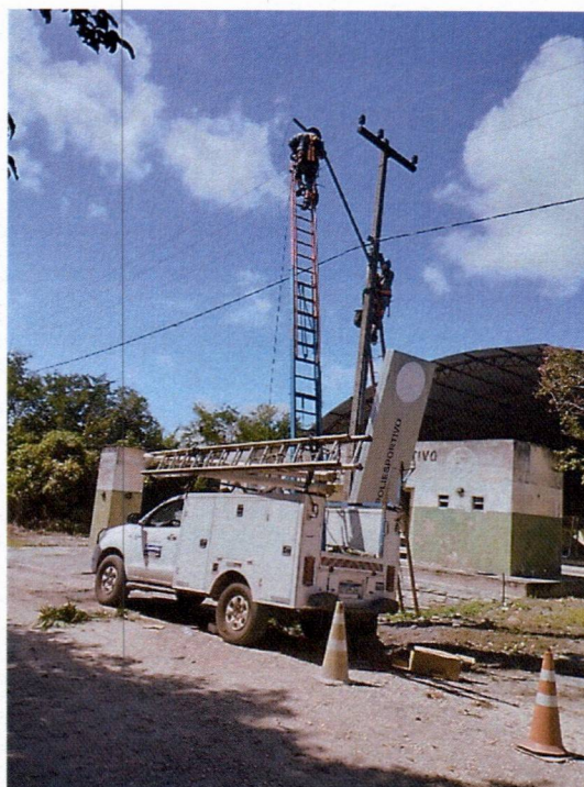
Figura 07: equipe em campo realizando substituições necessárias de Lâmpadas, cabo elétrico, conector, reator, arruela, braços com caminhonete adaptada.
