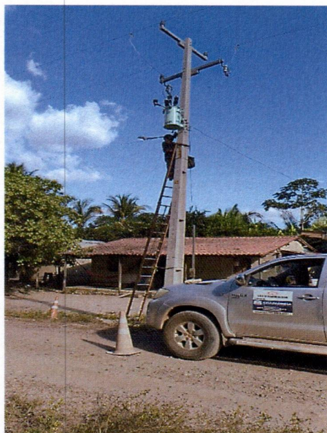
Figura 01: equipe em campo realizando substituições necessárias de Lâmpadas, cabo elétrico, conector, reator, arruela, braços com caminhonete adaptada.
