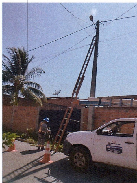
Figura 02: equipe em campo realizando substituições necessárias de Lâmpadas, cabo elétrico, conector, reator, arruela, braços com caminhonete adaptada.
