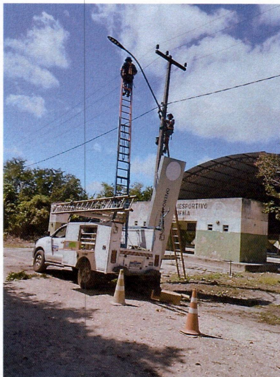
Figura 09: equipe em campo realizando substituições necessárias de Lâmpadas, cabo elétrico, conector, reator, arruela, braços com caminhonete adaptada.
