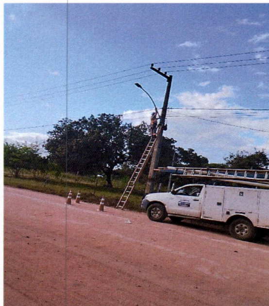
Figura 02: equipe em campo realizando substituições necessárias de Lâmpadas, cabo elétrico, conector, reator, arruela, braços com caminhonete adaptada.
