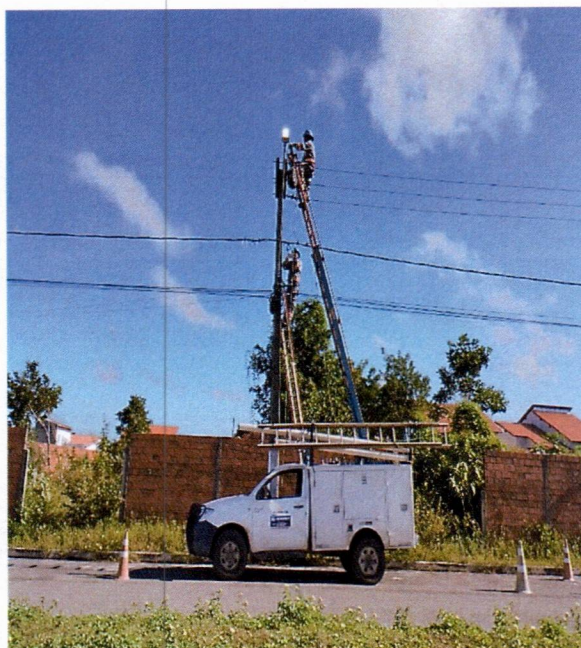
Figura 03: equipe em campo realizando substituições necessárias de Lâmpadas, cabo elétrico, conector, reator, arruela, braços com caminhonete adaptada.
