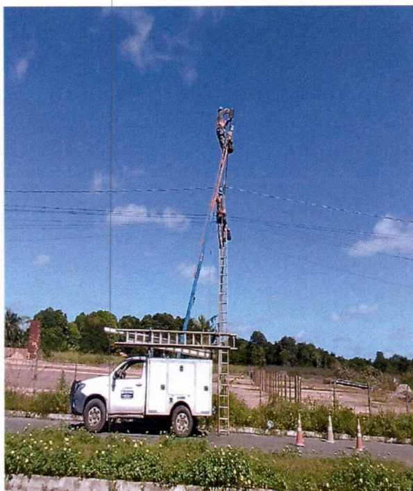
Figura 05: equipe em campo realizando substituições necessárias de Lâmpadas, cabo elétrico, conector, reator, arruela, braços com caminhonete adaptada.
