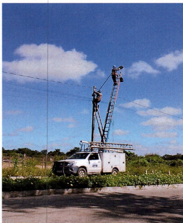
Figura 06: equipe em campo realizando substituições necessárias de Lâmpadas, cabo elétrico, conector, reator, arruela, braços com caminhonete adaptada.
