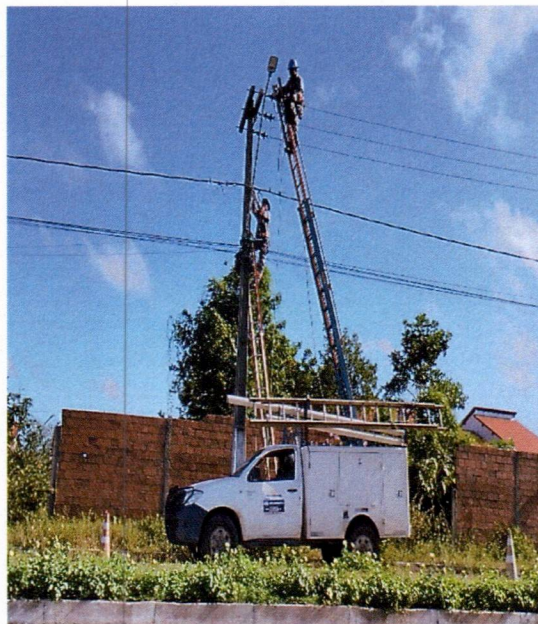
Figura 01: equipe em campo realizando substituições necessárias de Lâmpadas, cabo elétrico, conector, reator, arruela, braços com caminhonete adaptada.
