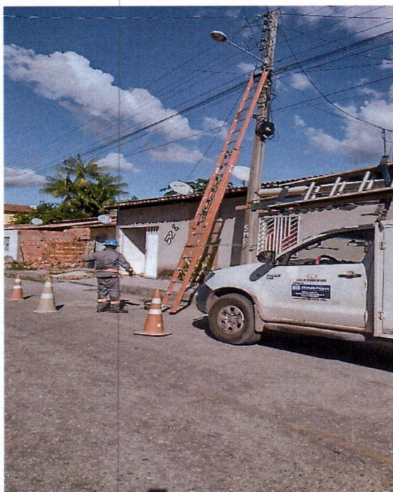
Figura 10: equipe em campo realizando substituições necessárias de Lâmpadas, cabo elétrico, conector, reator, arruela, braços com caminhonete adaptada.
