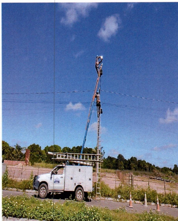
Figura 07: equipe em campo realizando substituições necessárias de Lâmpadas, cabo elétrico, conector, reator, arruela, braços com caminhonete adaptada.
