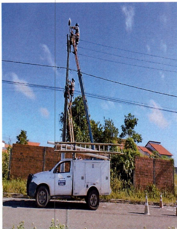
Figura 09: equipe em campo realizando substituições necessárias de Lâmpadas, cabo elétrico, conector, reator, arruela, braços com caminhonete adaptada.
