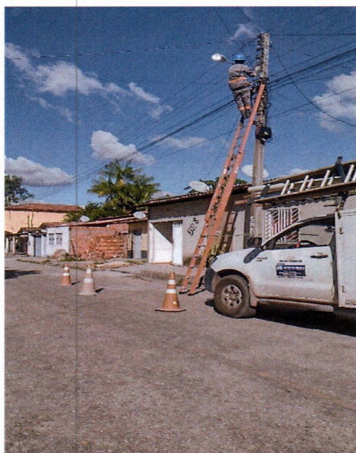
Figura 12: equipe em campo realizando substituições necessárias de Lâmpadas, cabo elétrico, conector, reator, arruela, braços com caminhonete adaptada.
