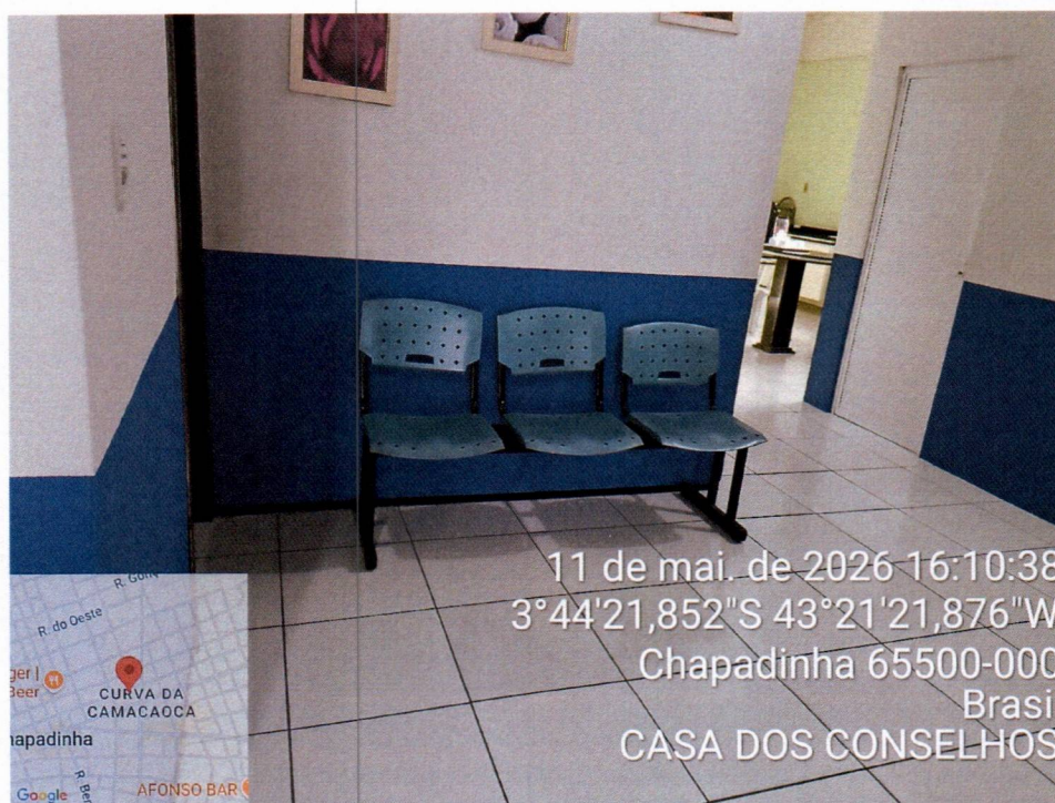
Imagem 4 – Execução da pintura interna.
