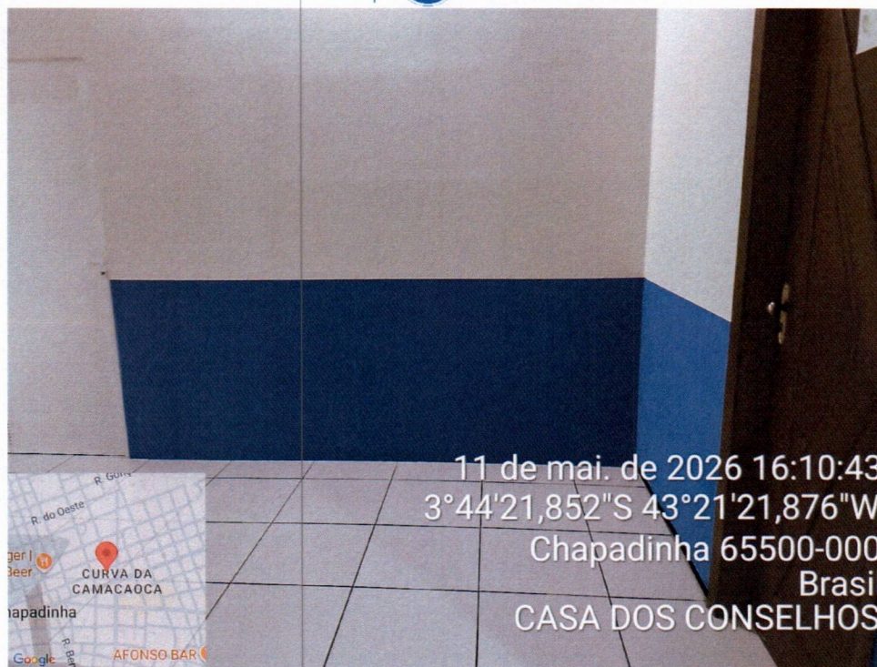
Imagem 5 – Execução da pintura interna.
