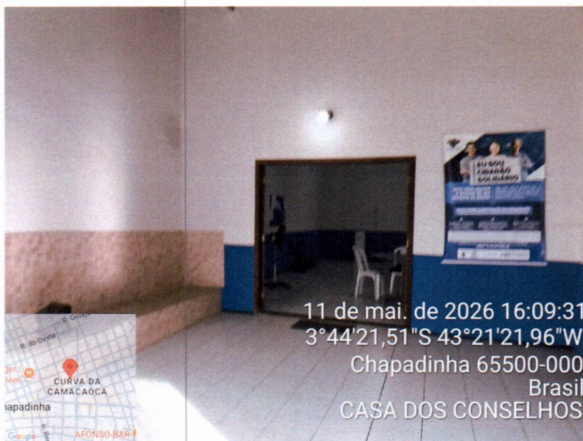
Imagem 2 – Execução da pintura interna e substituição de lampadas de led.
