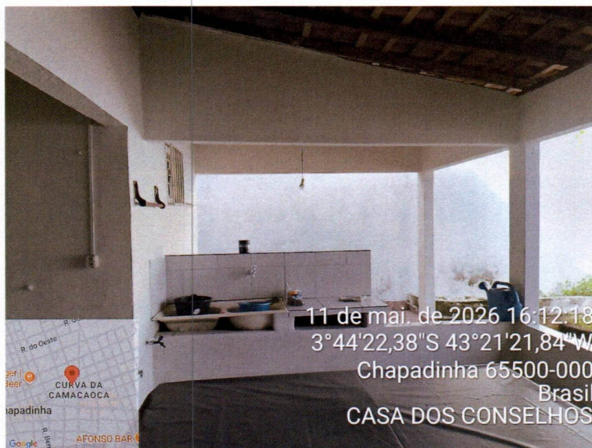
Imagem 9 – Execução da pintura externa.
