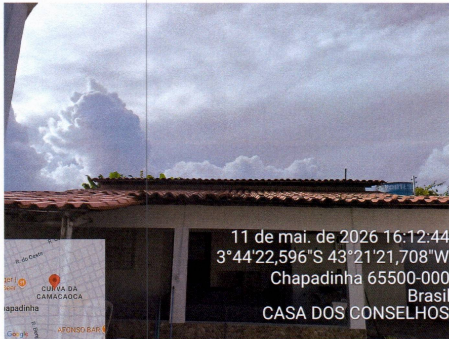
Imagem 11 – Execução dos serviços de retelhamento.
