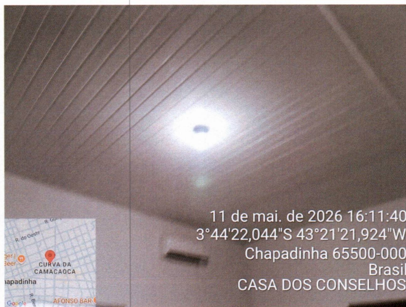
Imagem 10 – Substituição das lampadas de led.
