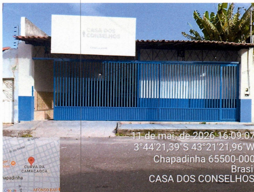
Imagem 1 – Execução da pintura externa e da pintura das grades.
