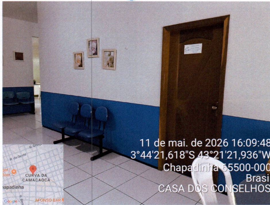
Imagem 7 – Execução da pintura interna.
