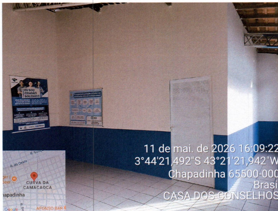
Imagem 3 – Execução da pintura interna.
