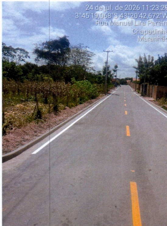
Imagem 06 – SERVIÇOS DE PINTURA DE FAIXAS E EIXOS
