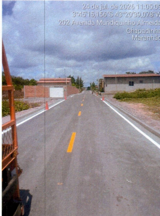
Imagem 02 – SERVIÇOS DE PINTURA DE FAIXAS E EIXOS
