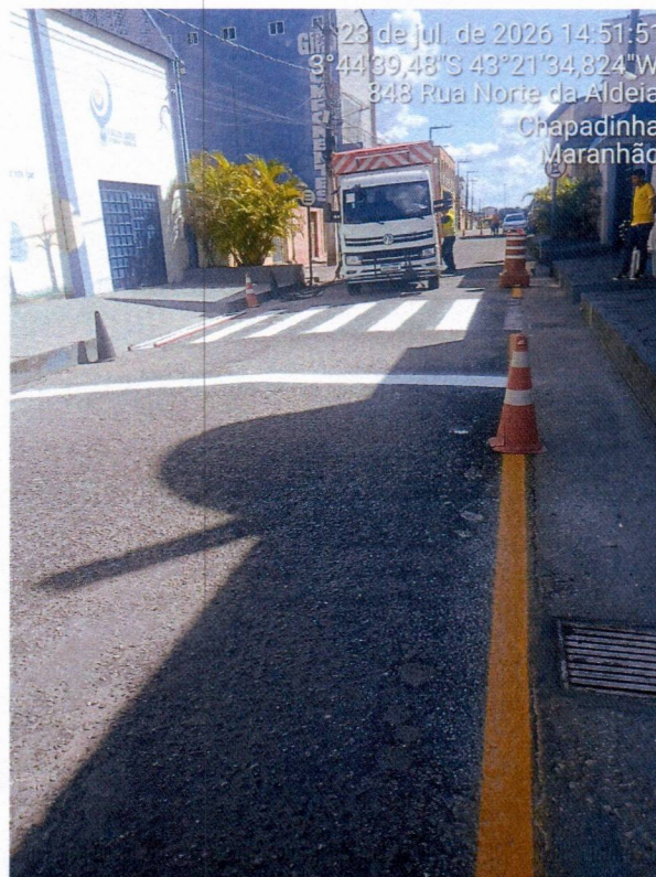
Imagem 03 – SERVIÇOS DE PINTURA DE FAIXAS E EIXOS
