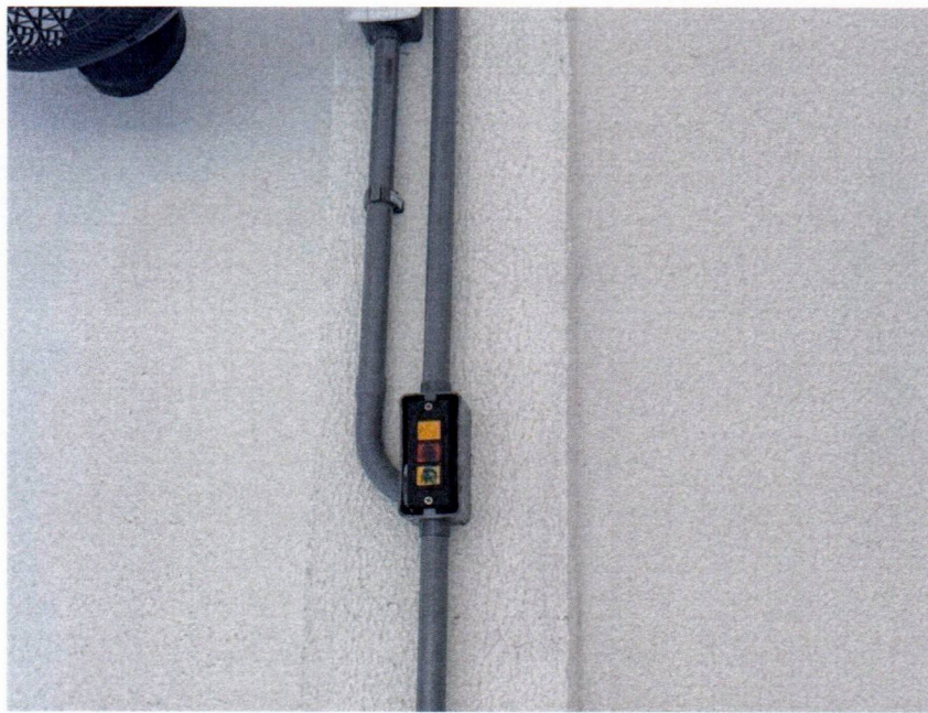
Imagem 02 – Serviços de instalações elétricas
