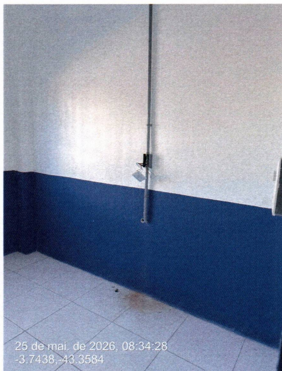
Imagem 08 – Serviços de pintura
