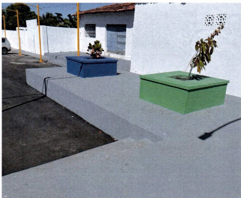
Imagem 05 – Serviços de bancos de concreto
