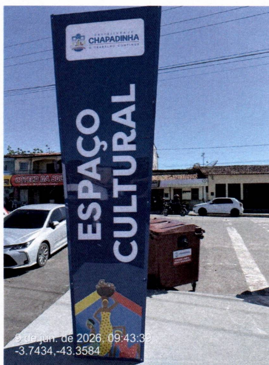
Imagem 04 – Serviços de estrutura revestida de ACM
