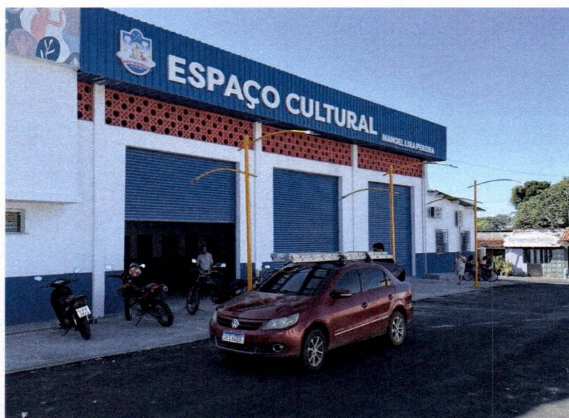
Imagem 11 – Serviços de pintura, estrutura em ACM e letreiro
