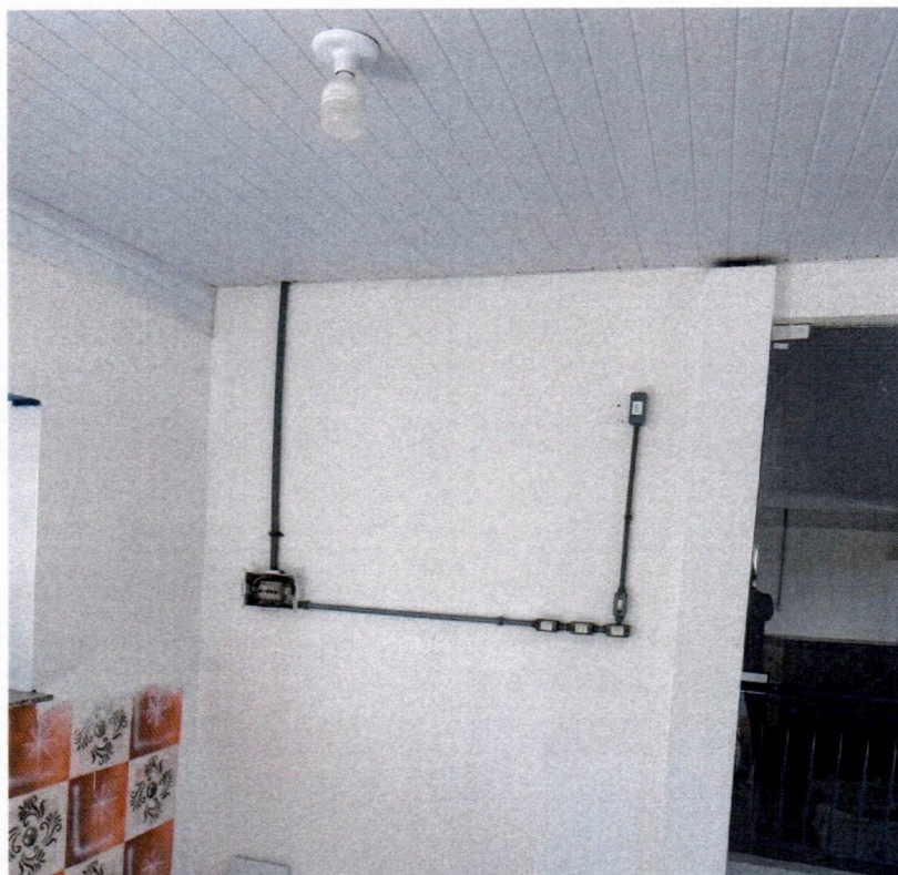
Imagem 10 – Serviços de instalações elétricas e luminárias
