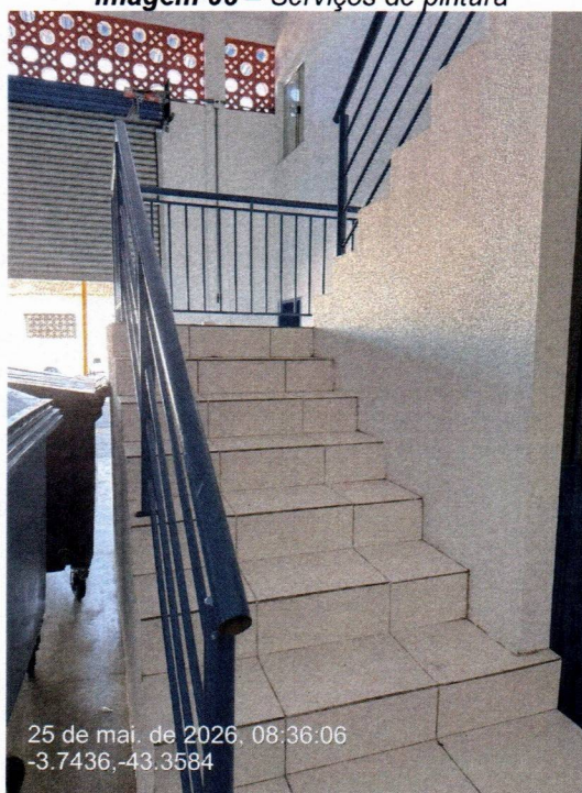
Imagem 09 – Serviços de pintura
