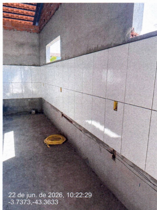
Imagem 07 – Serviços de revestimentos cerâmicos
