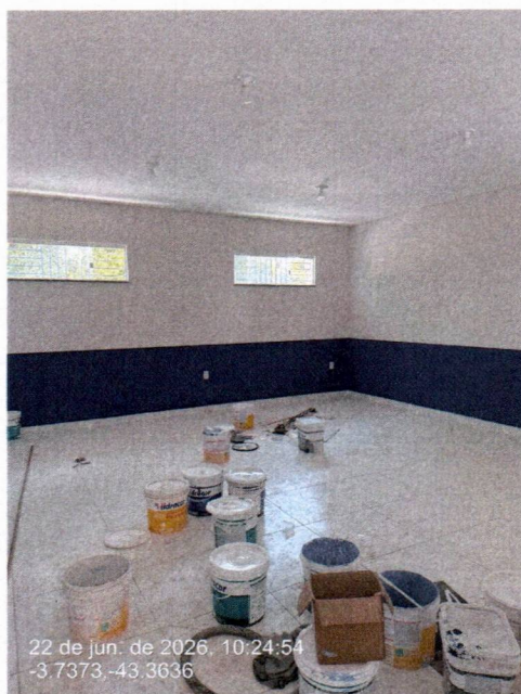
Imagem 13 – Serviços de pintura
