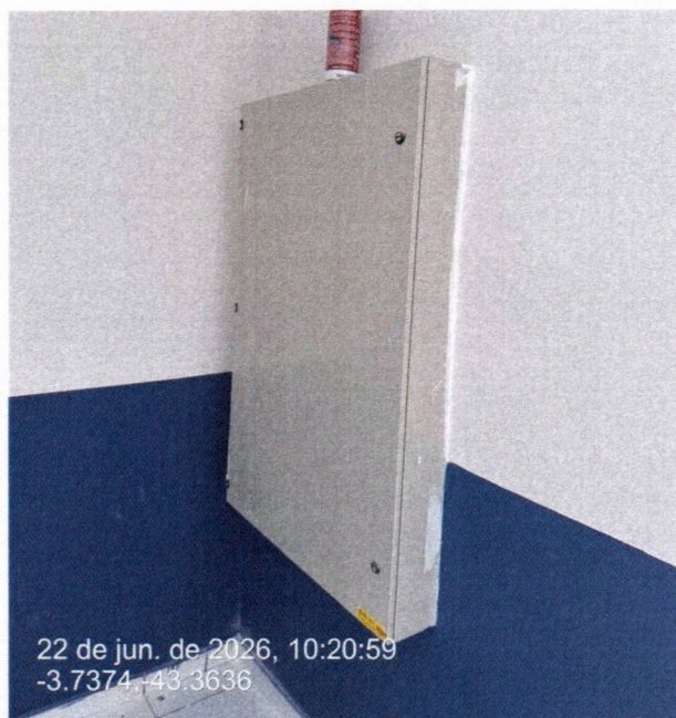
Imagem 02 – Serviços de quadros elétricos
