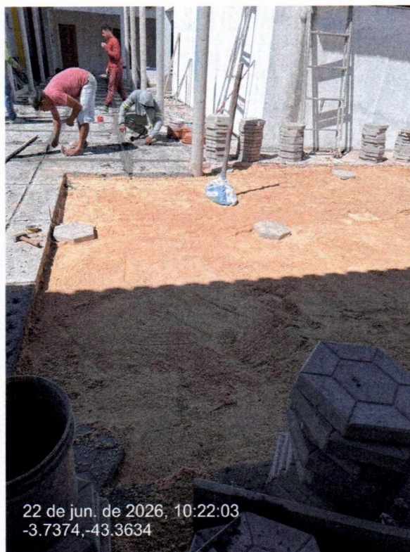
Imagem 04 – Serviços de piso em blocos intertravados e colchão de areia
