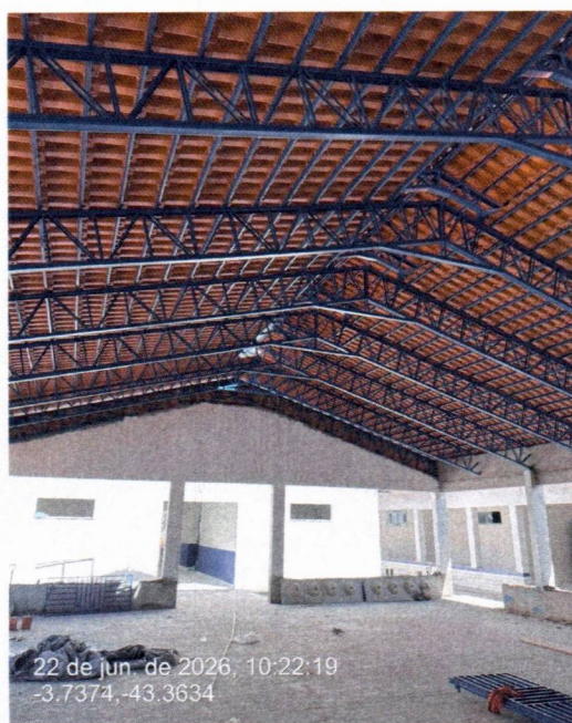
Imagem 06 – Serviços de cobertura em telha cerâmica
