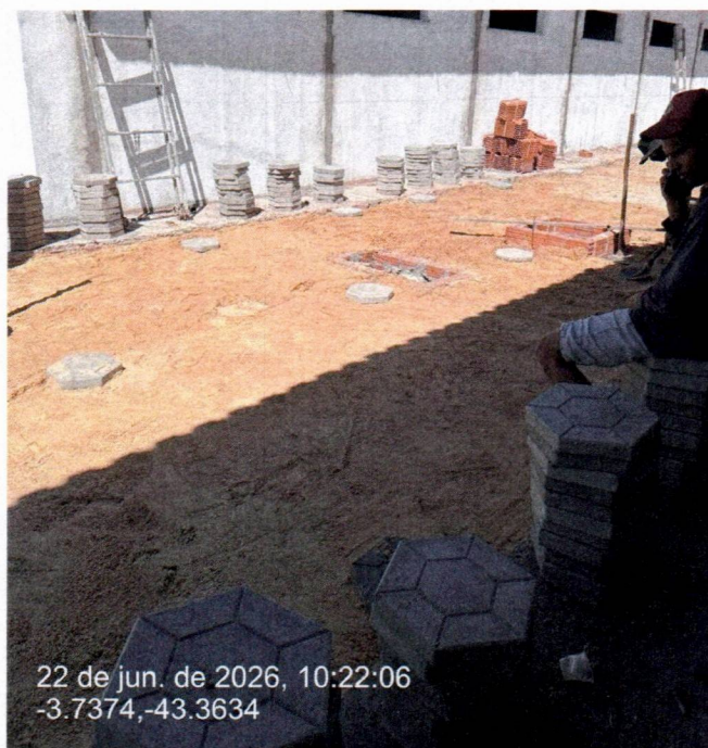
Imagem 05 – Serviços de piso em blocos intertravados e colchão de areia
