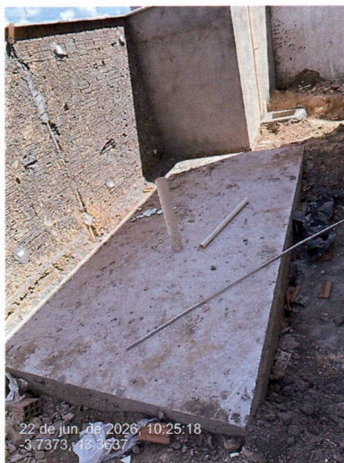
Imagem 15 – Execução da fossa septica.
