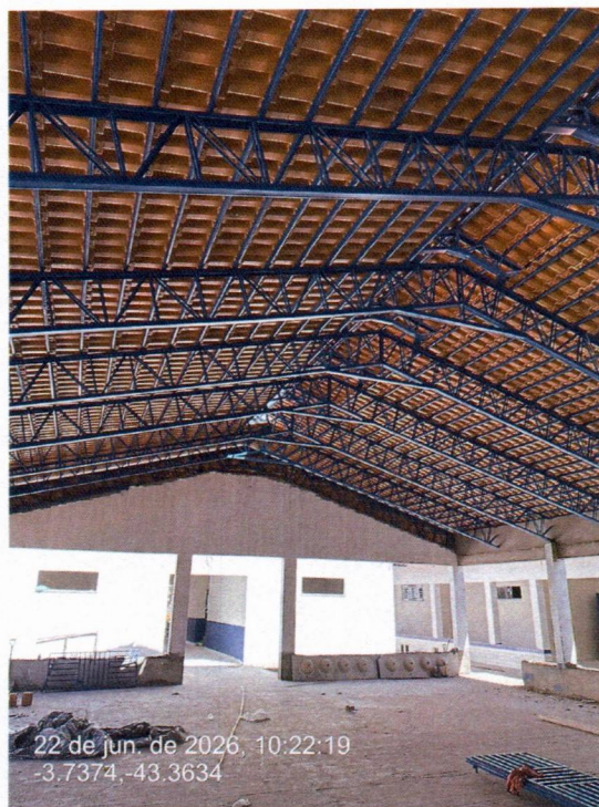
Imagem 7 – Execução da cobertura com telha ceramica e aplicação de selador no patio.
