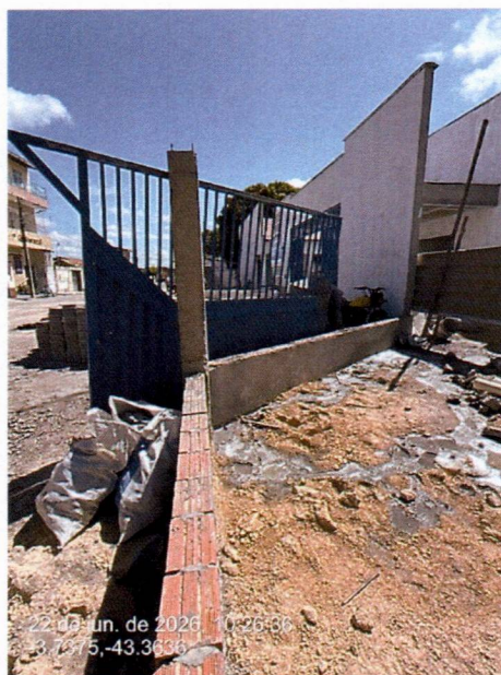
Imagem 1 – Execução da alvenaria da fachada.
