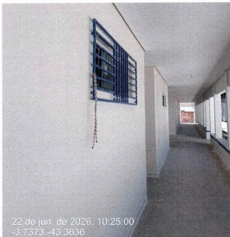
Imagem 14 – Serviços de pintura e grades metálicas
