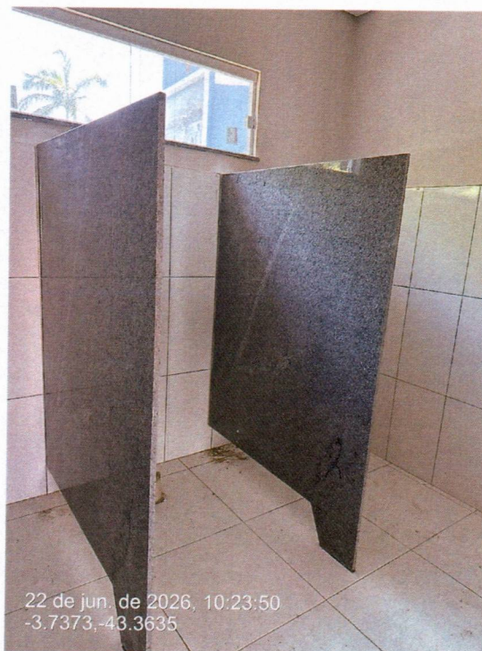
Imagem 14– Assentamento das divisorias de granito.
