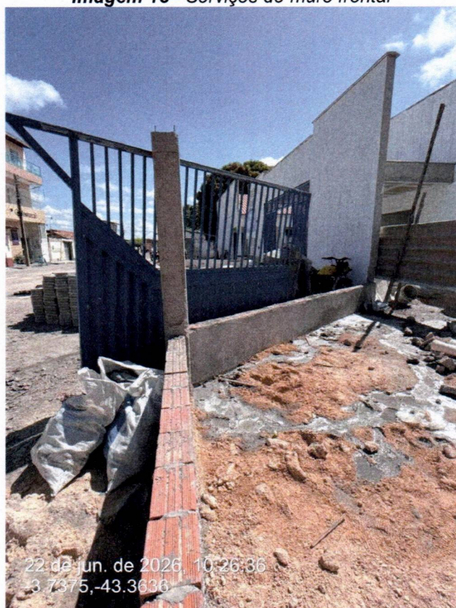
Imagem 19 – Serviços de muro frontal
