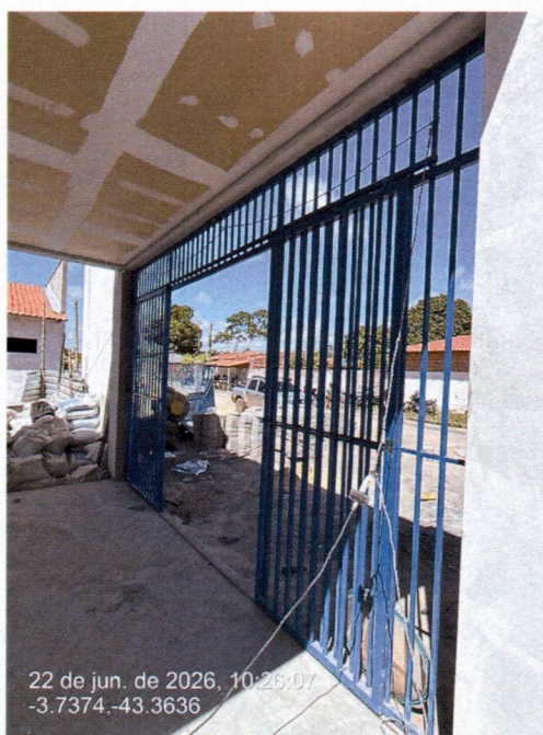
Imagem 16 – Instalação do portão metálico.
