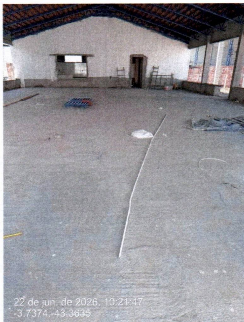
Imagem 08 – Serviços de piso em granilite
