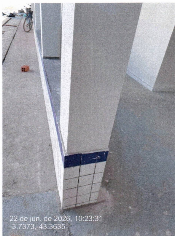
Imagem 10 – Serviços de revestimentos cerâmicos
