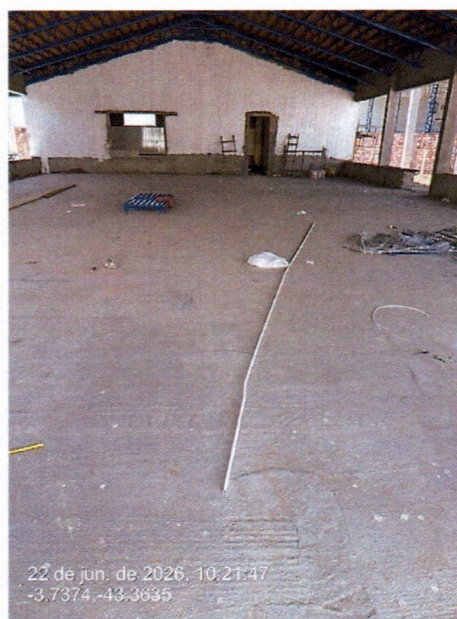
Imagem 12 – Execução do piso granilite.
