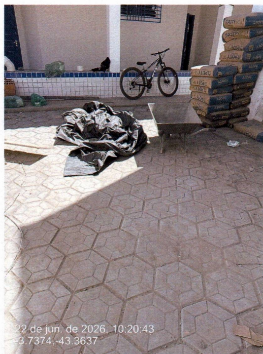
Imagem 4 – Execução do assentamento dos blocos de concreto.
