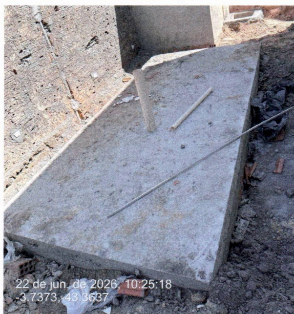
Imagem 15 – Serviços de instalações sanitárias, fossa e sumidouro
