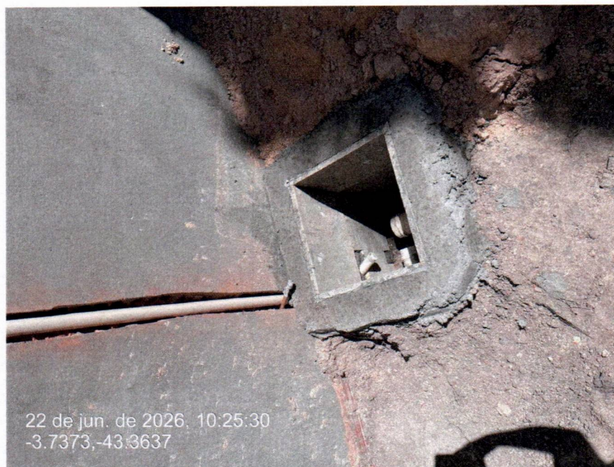
Imagem 20 – Serviços instalações sanitárias
