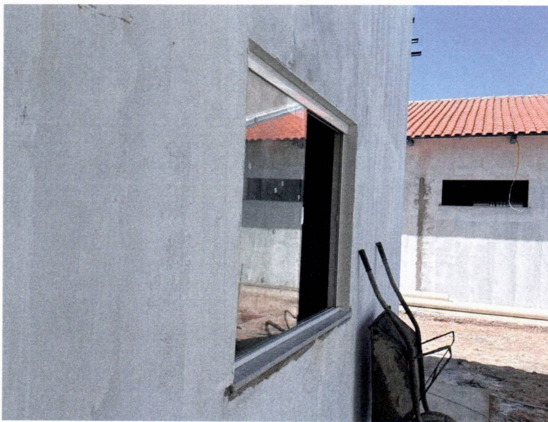
Imagem 01 – Serviços de pintura e esquadrias de vidro
