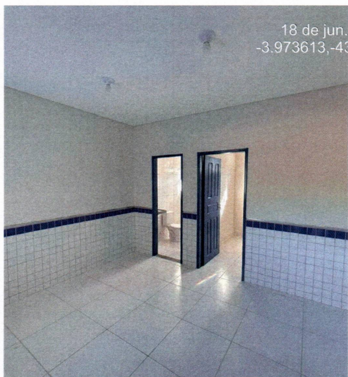
Imagem 05 – Serviços de piso e revestimento cerâmicos
