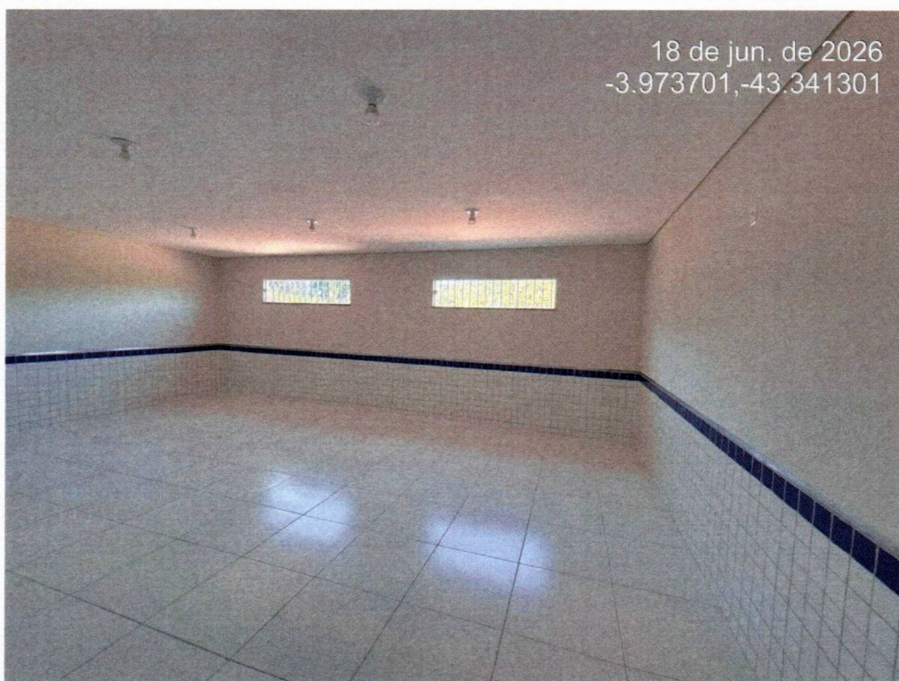
Imagem 07 – Serviços de revestimentos cerâmicos e forro
