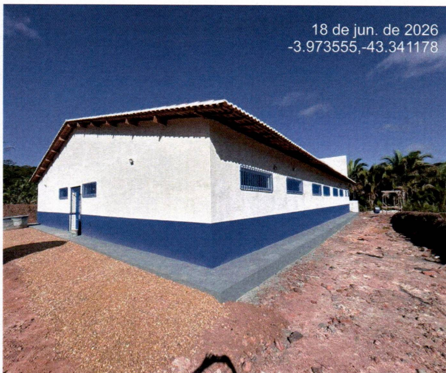
Imagem 14 – Serviços de pintura
