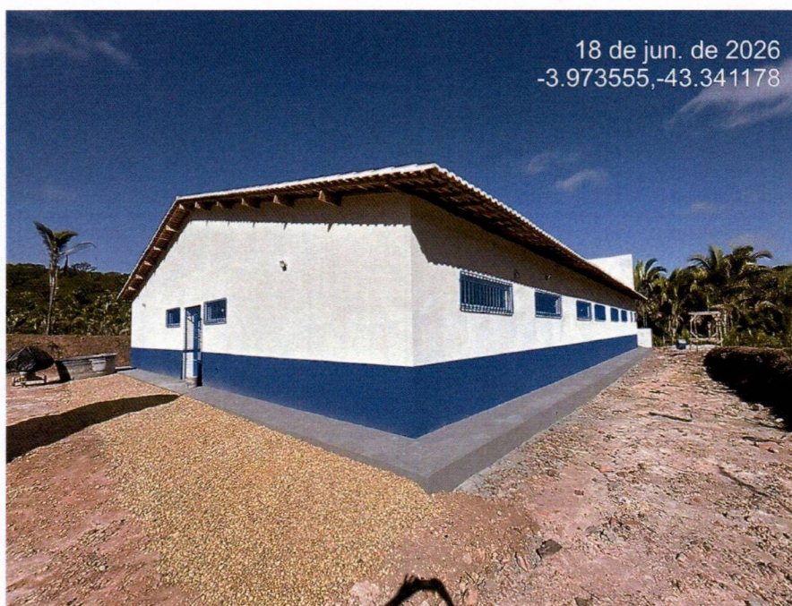
Imagem 2 – Execução da pintura externa e instalação das grades.
