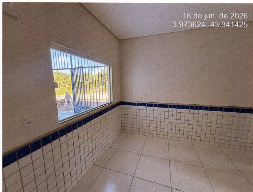
Imagem 9 – Execução do revestimento cerâmico 10x10 cm e pintura interna.
