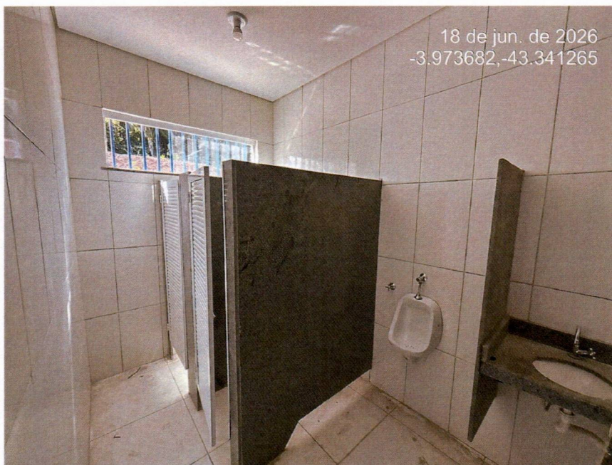
Imagem 14 – Execução do revestimento cerâmico dos banheiros e assentamento das bancadas de granito dos banheiros.
