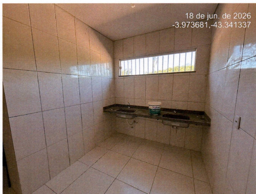
Imagem 12 – Execução do revestimento cerâmico da cozinha e assentamento das bancadas em granito.
