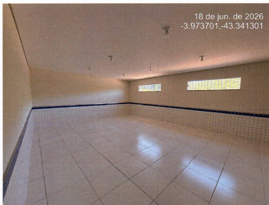
Imagem 10 – Execução do revestimento cerâmico das salas de aula e pintura interna.
