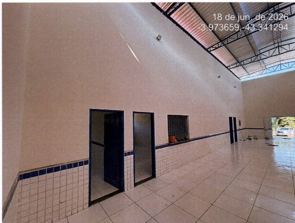
Imagem 6 – Execução da pintura interna e assentamento do revestimento cerâmico na escola.
