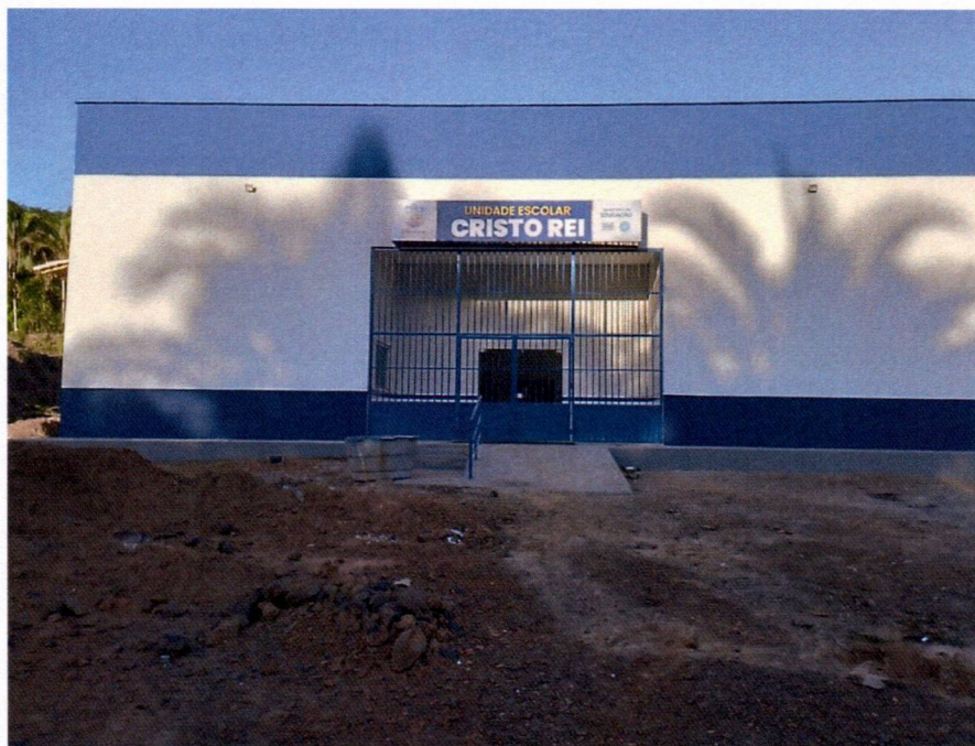
Imagem 1 – Execução da pintura externa e instalação da placa em acm.
