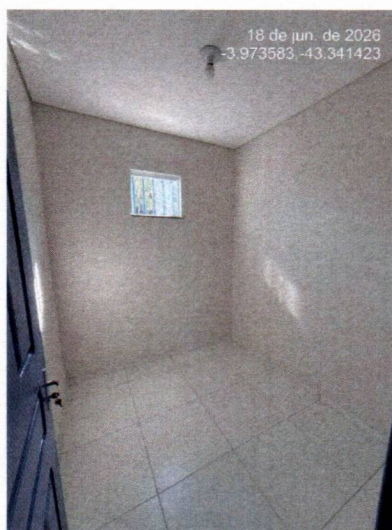
Imagem 04 – Serviços de piso de cerâmico
