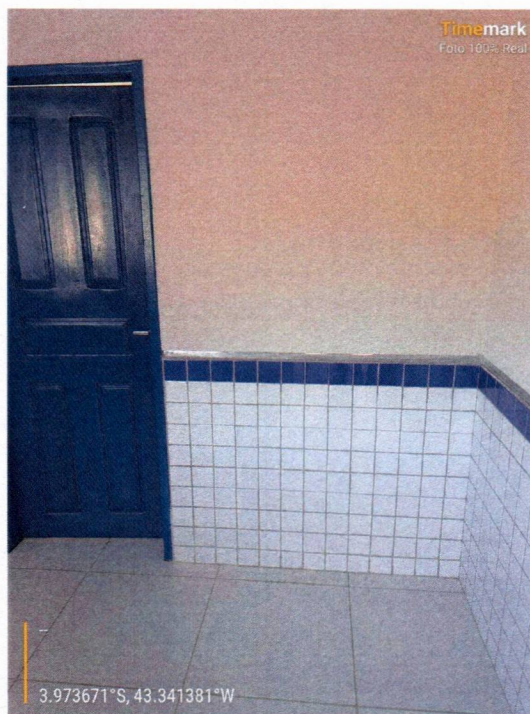
Imagem 02 – Serviços revestimentos cerâmicos
