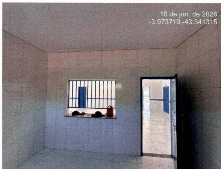
Imagem 06 – Serviços de revestimentos cerâmicos e forro
