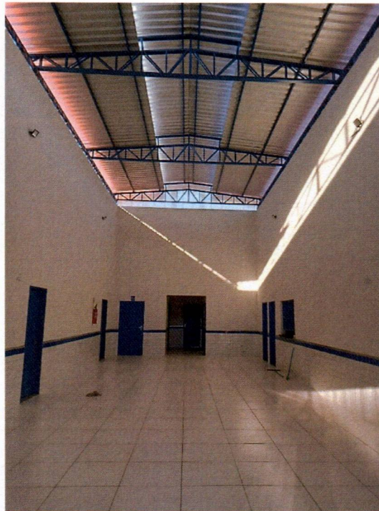
Imagem 5 – Execução da pintura interna e assentamento do revestimento cerâmico na escola.
