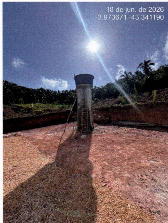
Imagem 12 – Serviços de estrutura de reservatório elevado
