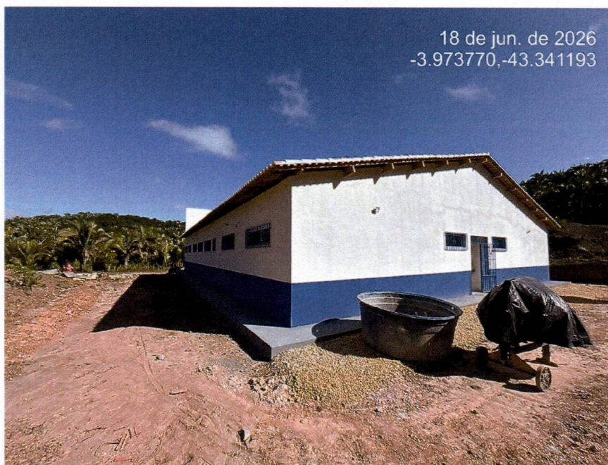
Imagem 3 – Execução da pintura externa e instalação das grades.
