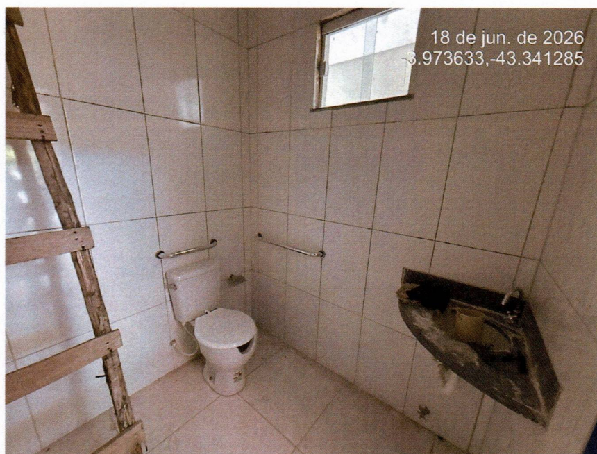
Imagem 15 – Execução do revestimento cerâmico dos banheiros e assentamento das bancadas de granito dos banheiros.
