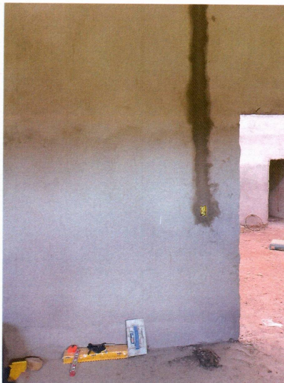
Imagem 7 – Execução do reboco interno e chumbamento das caixas de passagem.
