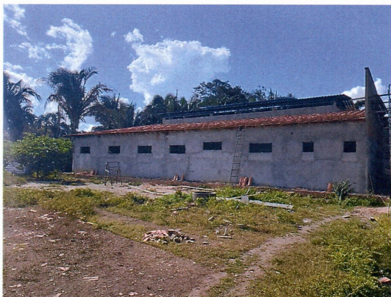
Imagem 2 – Execução da cobertura cerâmica da escola.
