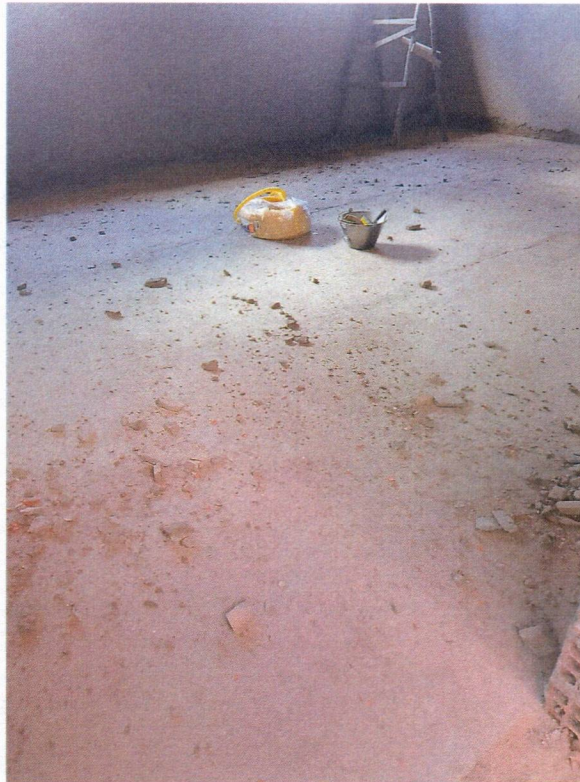
Imagem 9 – Execução do contrapiso interno.
