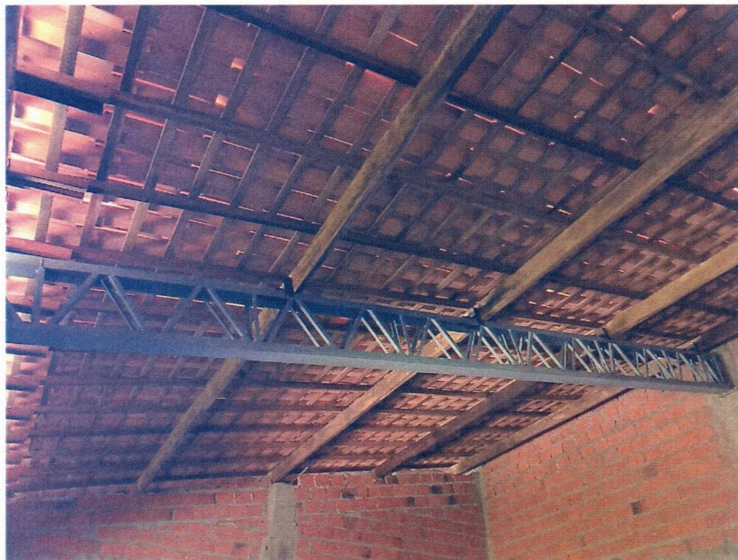
Imagem 5 – Execução da cobertura cerâmica da escola.
