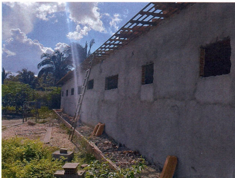
Imagem 3 – Execução da cobertura cerâmica da escola.
