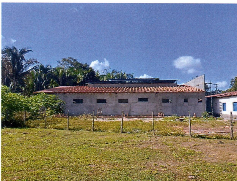
Imagem 1 – Execução da cobertura cerâmica da escola.
