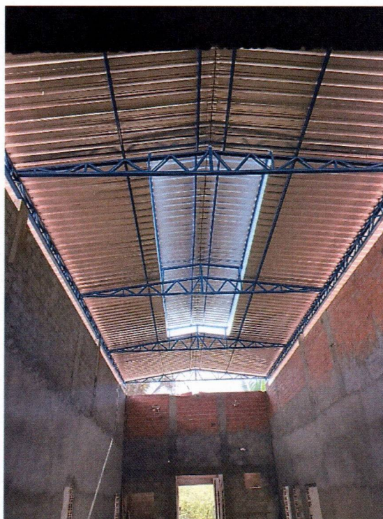
Imagem 6 – Execução da cobertura metálica do pátio.
