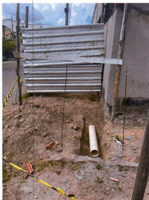
Imagem 2 – Execução de reboco e rede sanitária;
