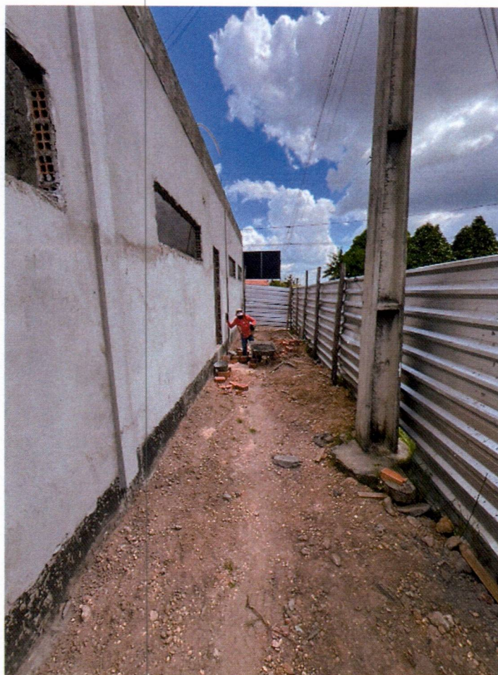
Imagem 21 – Execução da rede sanitária e rebocos externos;
