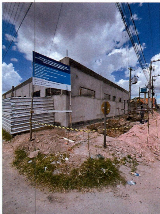
Imagem 1 – Execução de vigas e rebocos;
