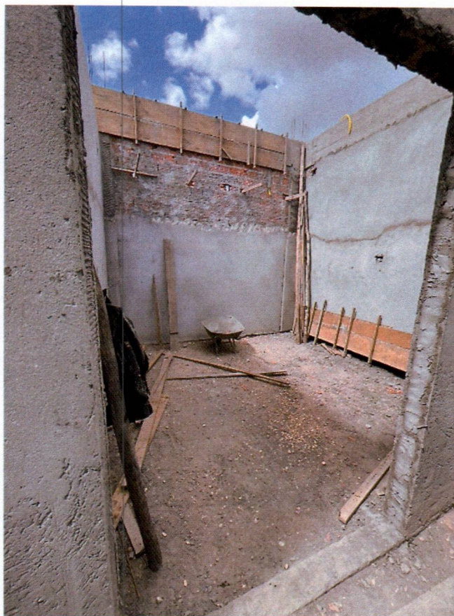
Imagem 17 – Execução de vigas, chapiscos e rebocos;
