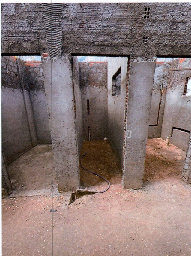
Imagem 6 – Execução de vigas, chapiscos e rebocos;
