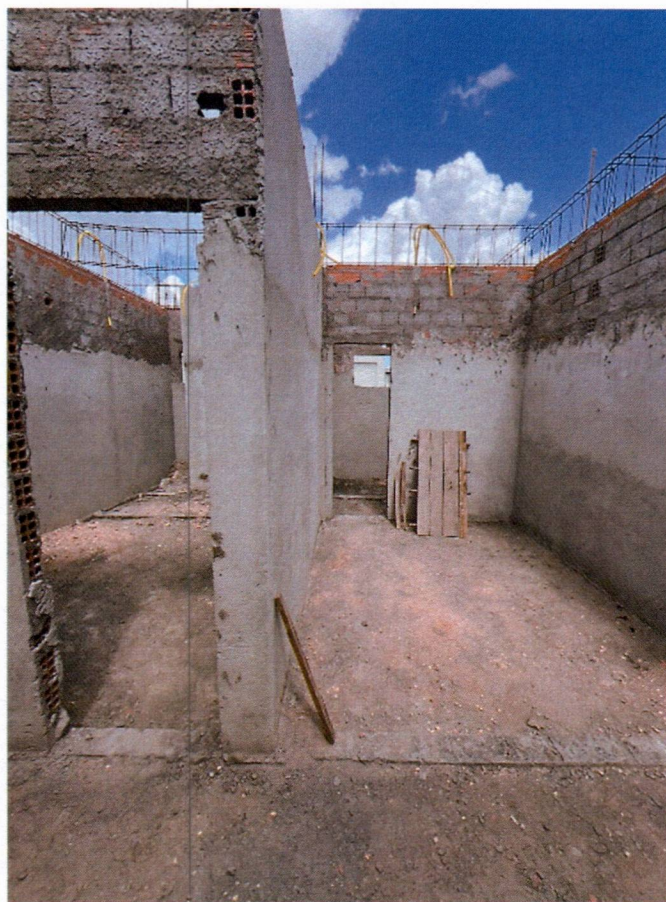
Imagem 9 – Execução de vigas, chapiscos e rebocos;
