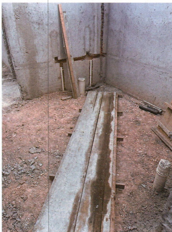
Imagem 18 – Execução da rede sanitária;
