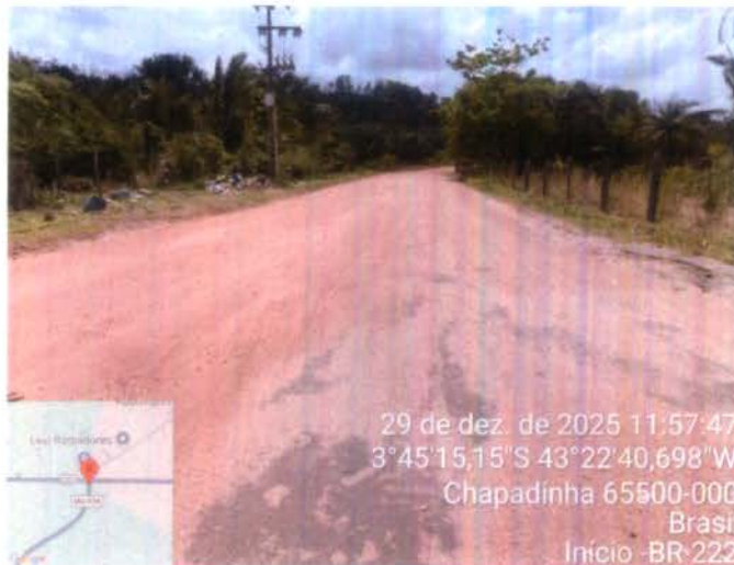
FOTO 1. INÍCIO DO TRECHO – KM 0,00.
