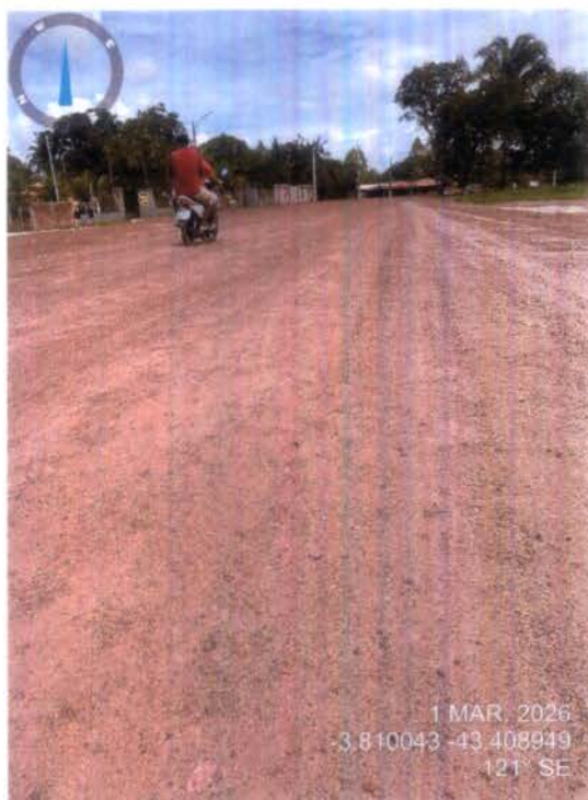
FOTO 11: KM - 2,90 (FIM DO TRECHO POVOADO MANGABEIRA)
