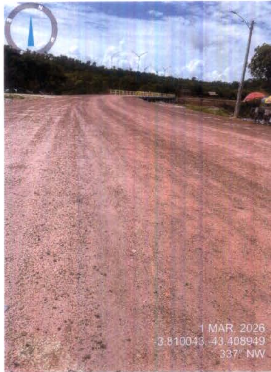
FOTO 12: KM - 2 ,90 (FIM DO TRECHO POVOADO MANGABEIRA)
